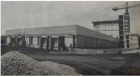
Noch im Bau: das Milupa-Werk 1982 Zu sehen ist das Produktionsgebäude (hinten) und das Lagergebäude (vorne)
